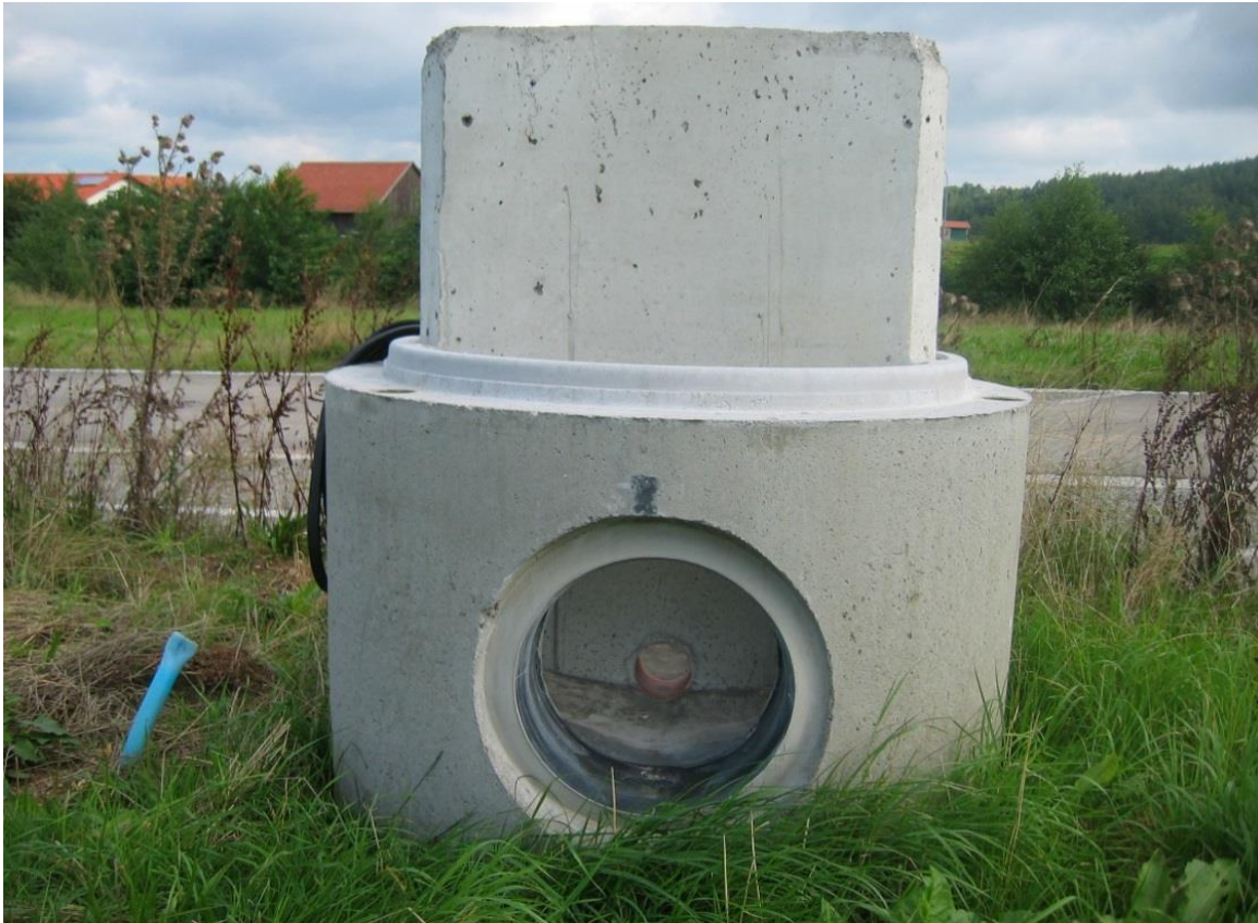
Bild 1: Schachtunterteil mit Drosselöffnung (Rohrdrossel d = 100 \text{ mm} )
