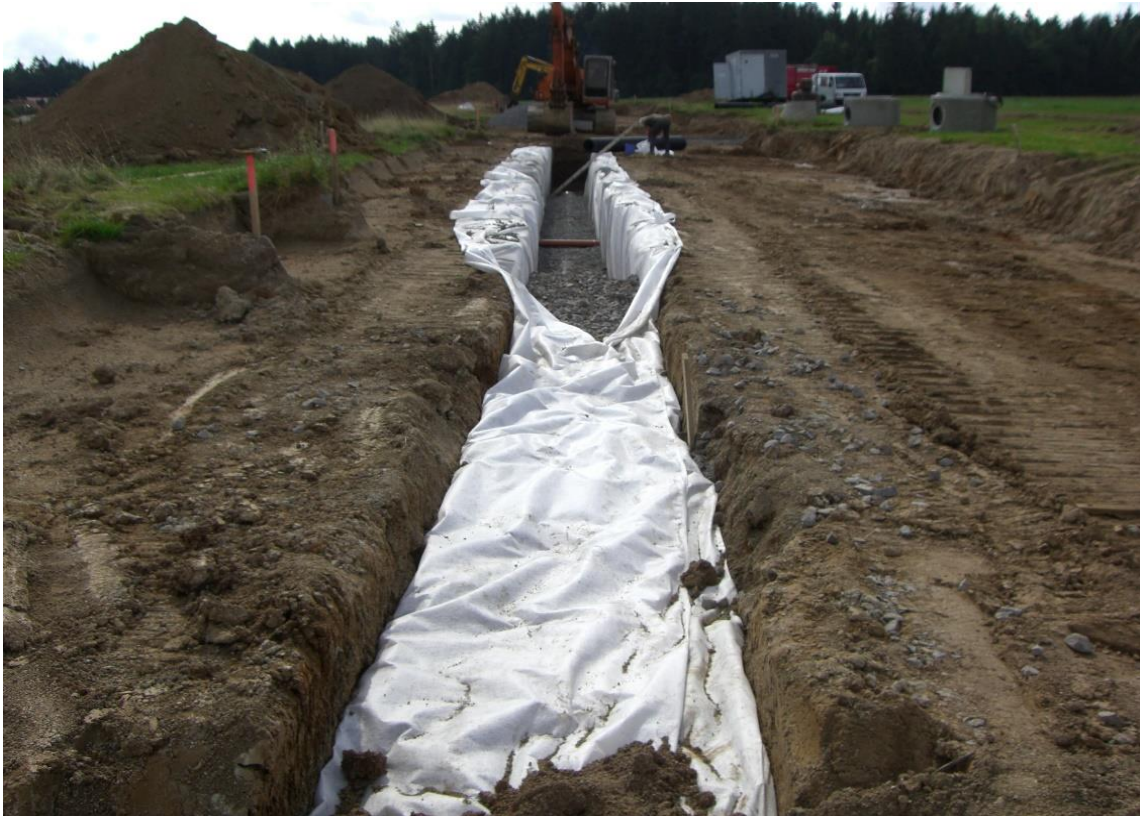
Bild 4: Geotextil-Vlies überlappend als Schutz vor Eintrag von Feinteilen
